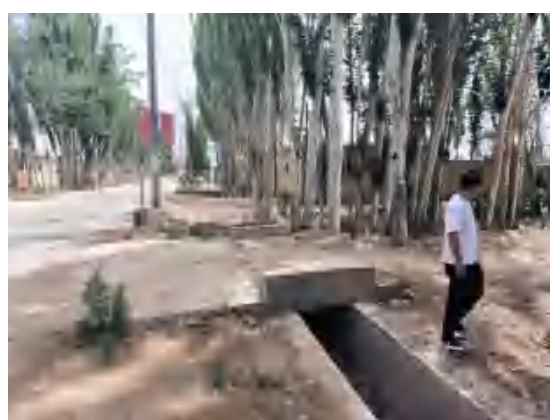
安业路塔格其村渠道
