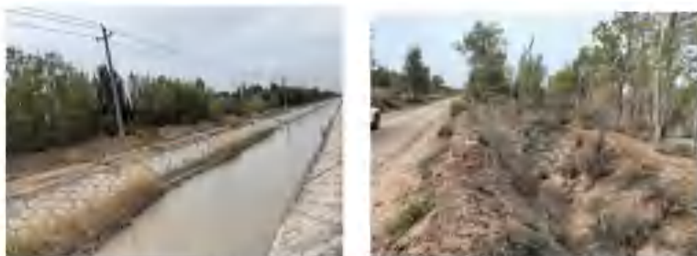
图 3.1-26 五支干渠供水管线、土渠
