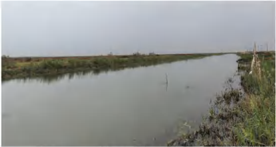
图 3.1-24 塔北一干排渠
