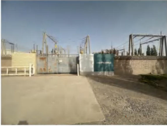
现场踏勘照片（现有变电站）
