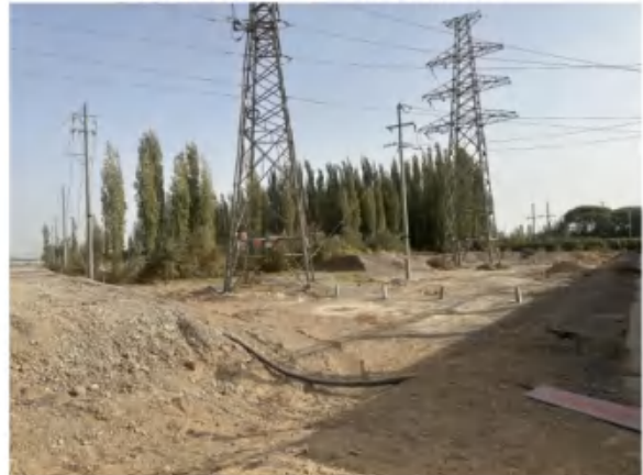
现场踏勘照片（现有杆塔）
