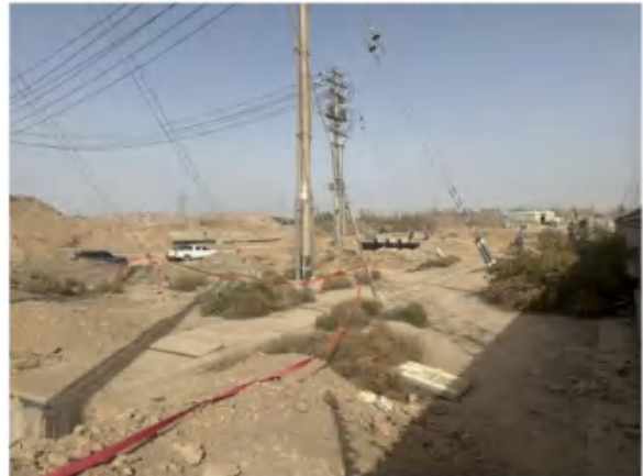
现场踏勘照片（现有杆塔）
