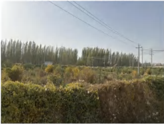
现场踏勘照片（现有输电线）
