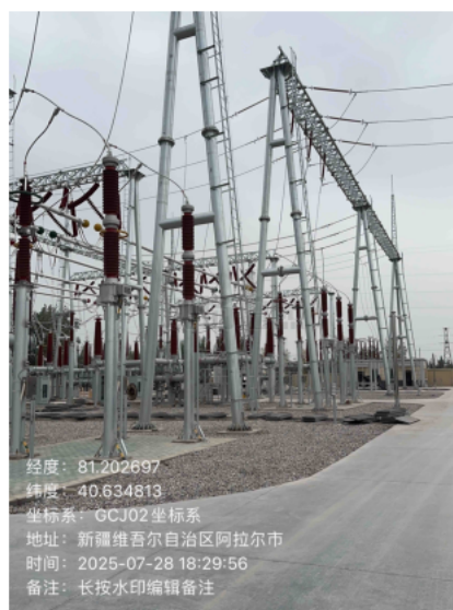
线路终点在建梨花镇变电站
