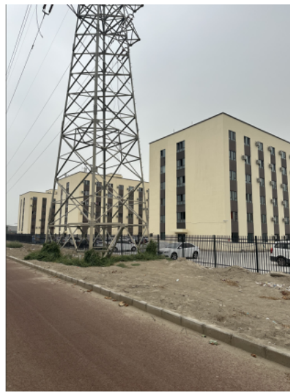
线路沿线宿舍楼
