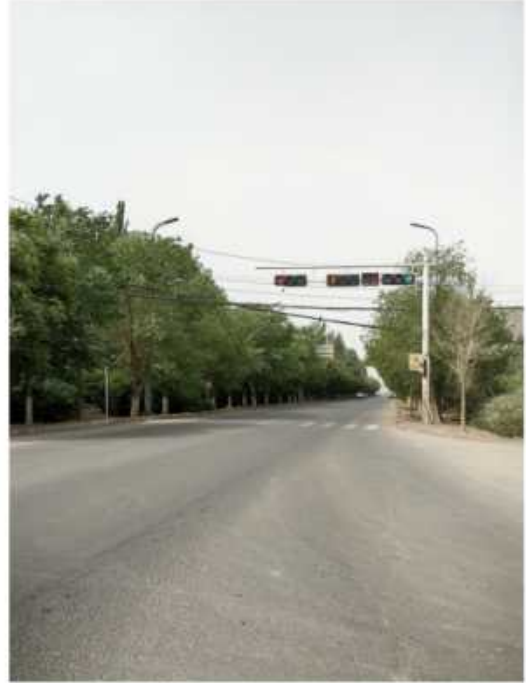
输电线路跨越道路
