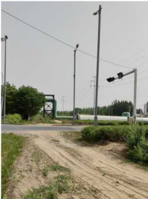
电缆钻越纬四路
