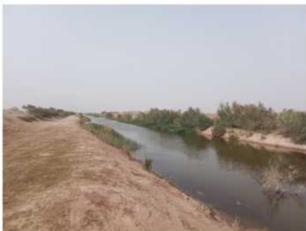
蒸汽管线旁排碱渠
